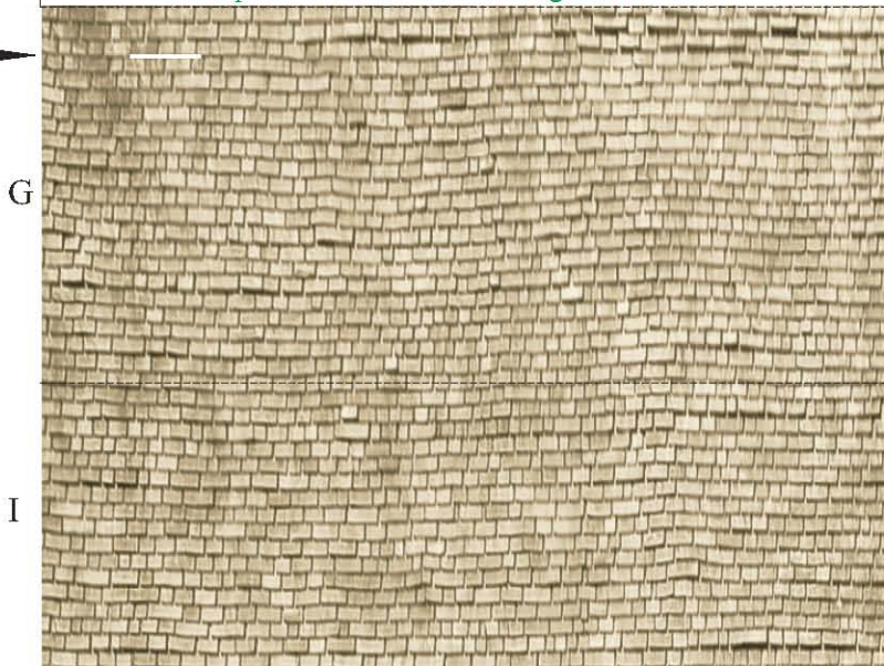
Bottom edge of Back Roof
